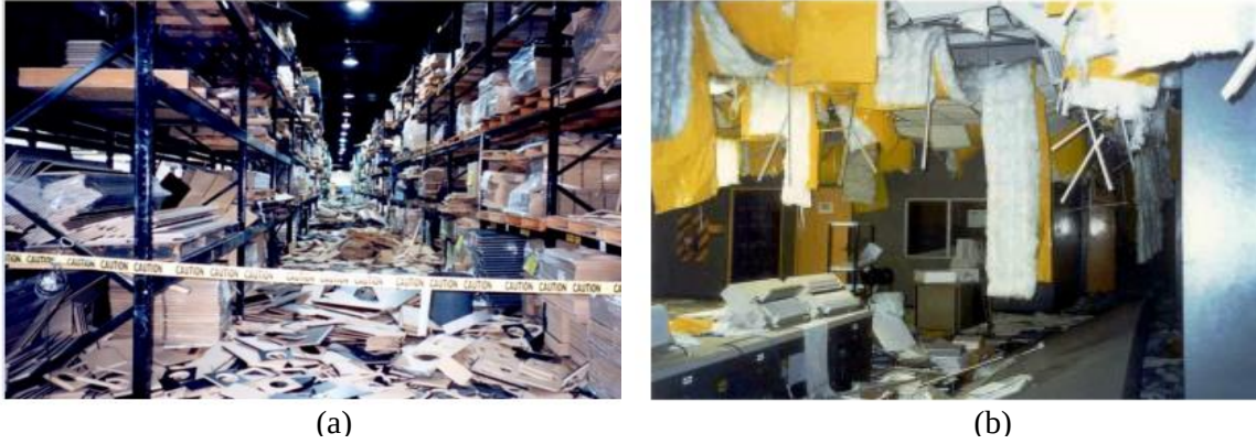
Şekil 1. (a) 1994 Northridge depremi sonrası ve, (b) 2001 Peru depremi sonrası oluşan yapısal olmayan hasarlar (FEMA E-74, 2011)
